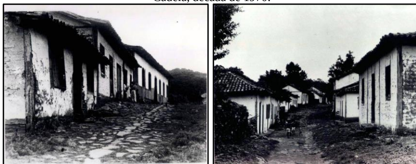
Figura 16: Calçamento em pedras de lajes e casarões. Rua Viracopos, década de 1970. Figura 17: Vestígios de calçamento em pedras de lajes e casarões. Rua da Cadeia, década de 1970.
